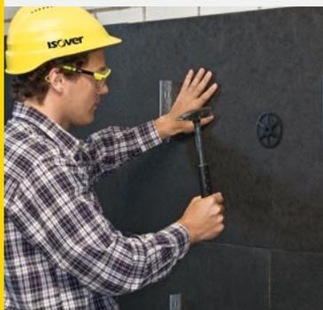
Die neue ULTIMATE Fassaden-Dämmplatte-035 Easy Fix passt sich flexibel dem Untergrund an und reduziert dadurch das Risiko von Hinterströmungen.
